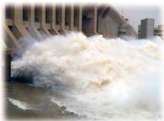
水电站泄洪场景
