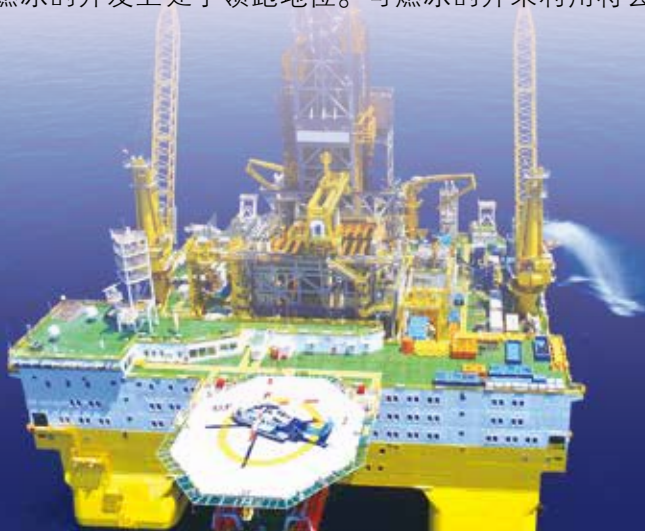
图3-2-4 可燃冰开采现场
